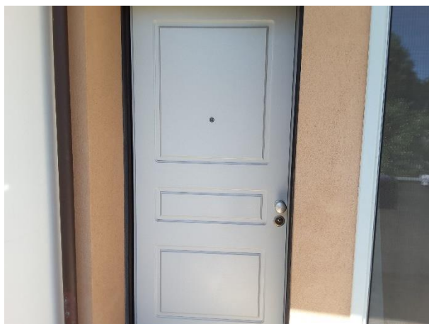
Vista portoncino d'ingresso all'abitazione
